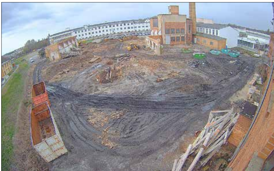
Blick auf die Baustelle am 10. März
