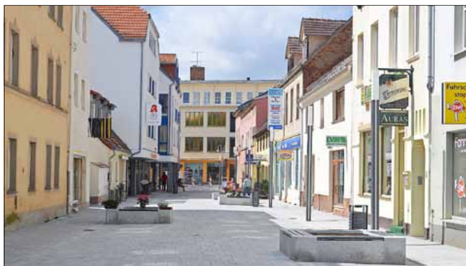
Die August-Bebel-Straße ist nach der Sanierung attraktiver geworden.
