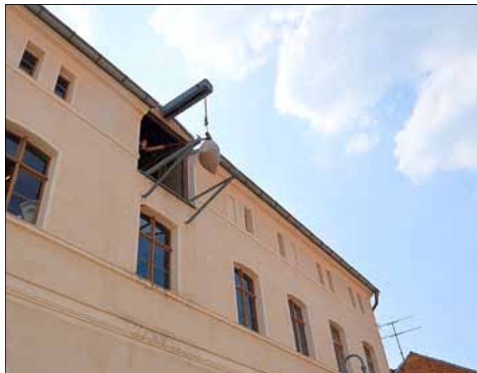
Vorführung des Original-Lastenaufzuges bei Ad. Bauers Wwe. in der Ringstraße.
